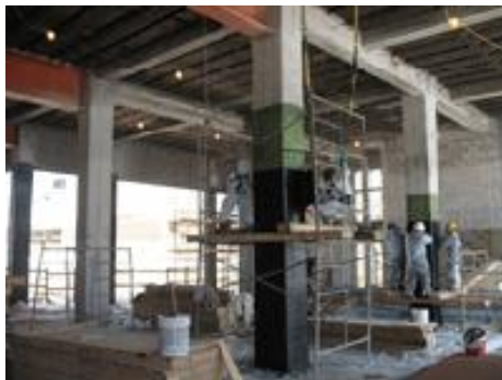
รูปที่ 5 การติดตั้งแผ่น FRP โดยวิธีโอบรัดองค์อาคารเสา
