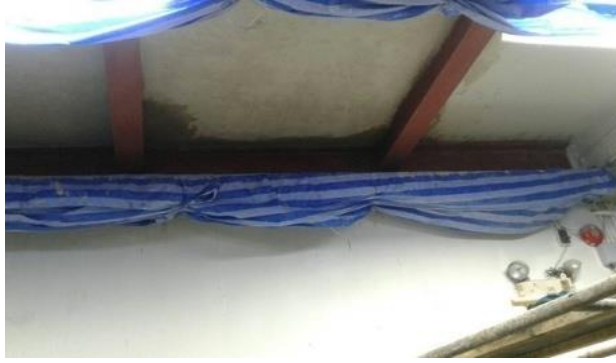
รูปที่ 12 การติดตั้งคานเหล็กเพิ่มเติมเพื่อเสริมความมั่นคงแข็งแรงของโครงสร้างพื้น
