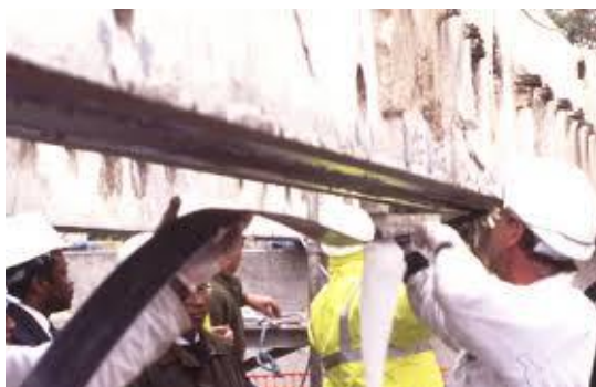
รูปที่ 6 การเสริมความกำลังชิ้นส่วนคานโดยใช้ FRP แบบแผ่นสำเร็จรูป (ที่มา : http://www-civ.eng.cam.ac.uk/cjb/frpdebond/index.html )
