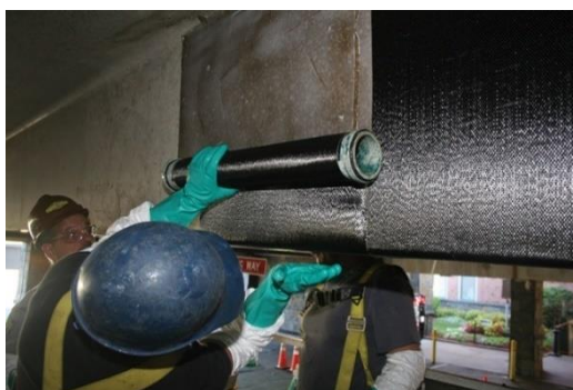
รูปที่ 7 การใช้ FRP แบบแผ่นเส้นใยแห้งเพื่อเสริมกำลังต้านทานแรงเฉือนของโครงสร้างคาน (ที่มา : https://www.structuremag.org/?p=8643 )
